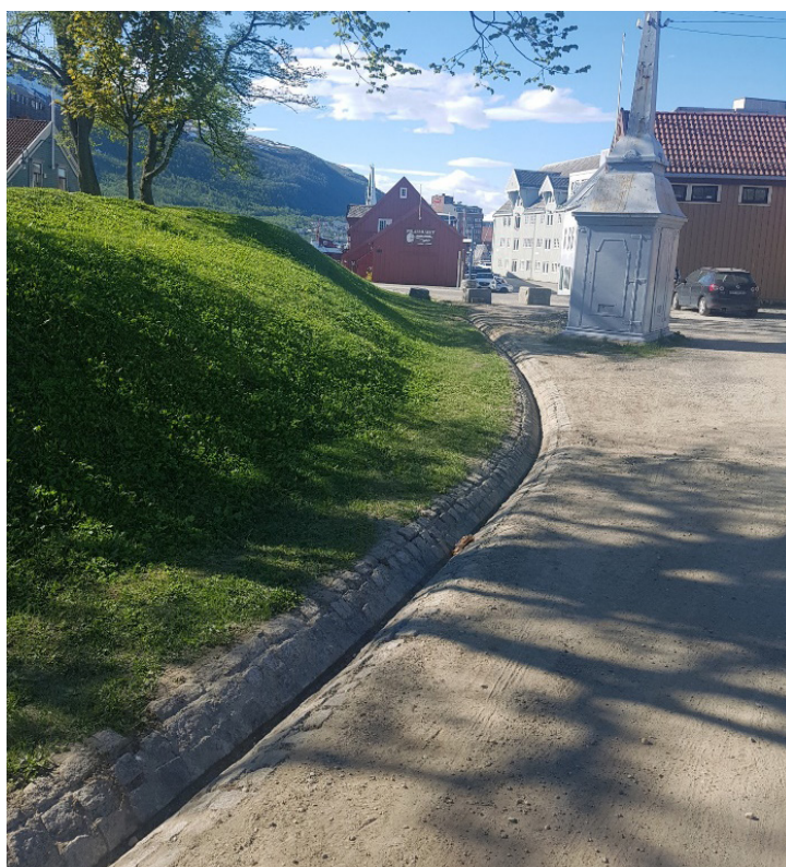
Bilde 14. Steinrenne som skal illustrere vollgraven i vest. Observasjoner av skader på vollen øst før steinrenna; p.g.a. kjøring og snørydding. Foto: Keth Lind, UM
