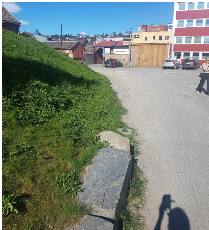
Bilde 6. Enden på støttemuren i nordøst. Foto: Keth Lind, UM 2022
