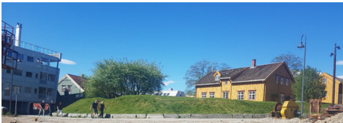
Bilde 3. Støttemuren i sør og øst oppført i 2014. Foto: Keth Lind, UM 2022
