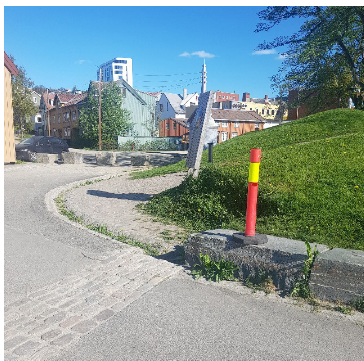
Bilde 5. Starten av støttemuren i sør, øst for adkomst til festningen. Foto: Keth Lind, UM 2022
