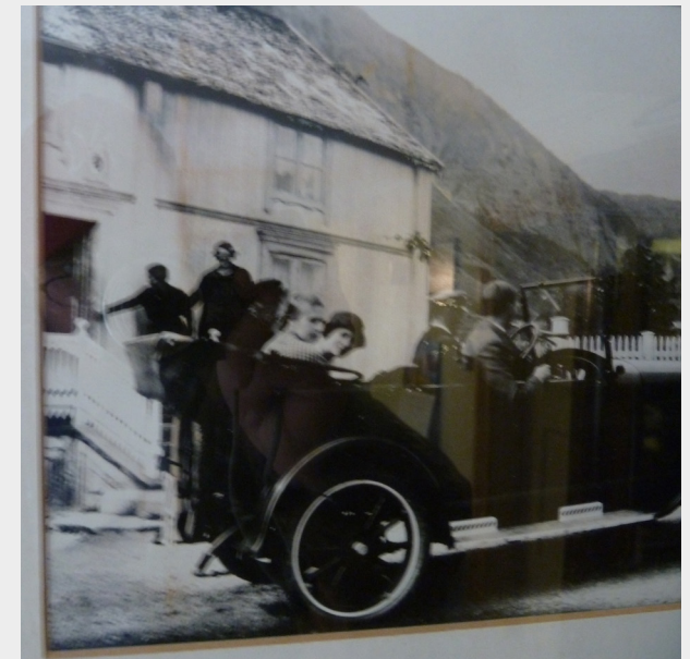
Fasade mot øst: på et bilde fra 1920-tallet. Taket var kledt med spon/stikker. Vi ser også det eldre trapperekverket.
