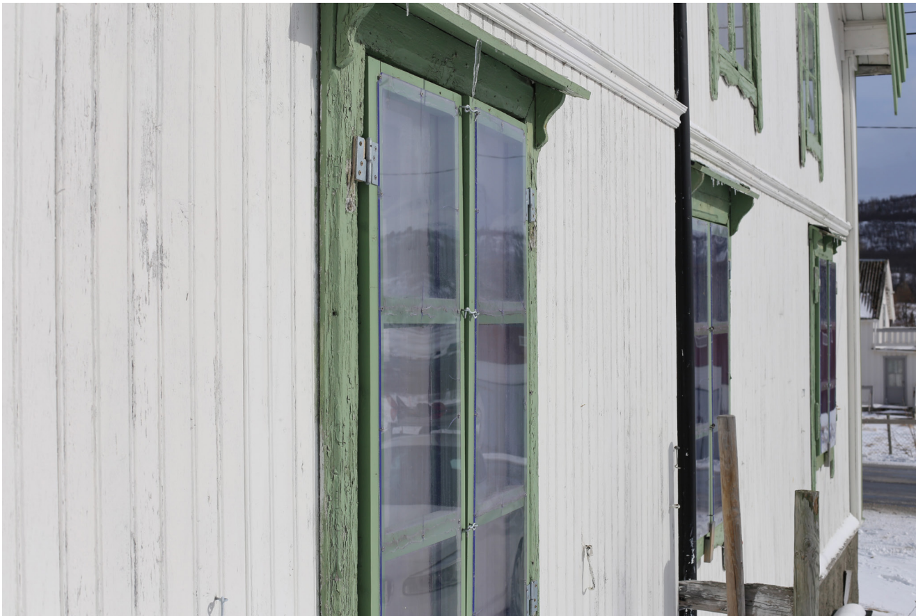
Flere vinduer har varevinduer med akrylglass for å beskytte de gamle vinduene mot stein- og snøsprøyt fra brøyting på fylkesveien. Bolighusets kledning er til største del dobbel perlestaff. Mot nordvest er det nyere liggende, skråskåret kledning.
