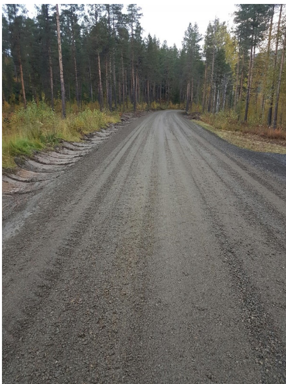
Figur 7 Oppgradert kommunal veg. Utnyttelse av eksisterende infrastruktur i utviklingen av Målselv kommune er viktig av økonomiske hensyn. Veger med høy kvalitet gir bolyst og trivsel.
