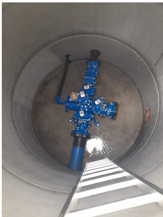
Figur 5: Viser kummen på vestsida av E6 som fører vann til N2 og videre nordover
