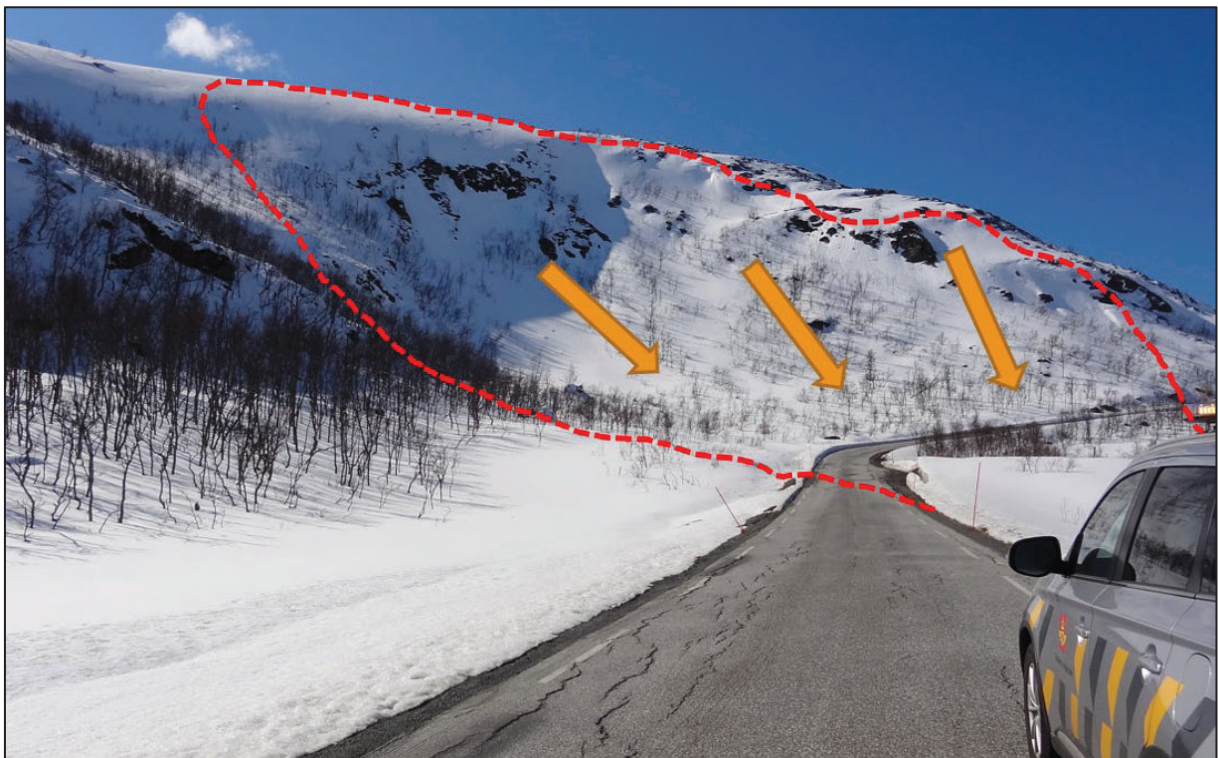
Figur 9: Skredområdet Bårsvikbukken 1 på FV7768 over Grøtfjordfjellet, foto mai 2021 Ole-André Helgaas, SVV.
