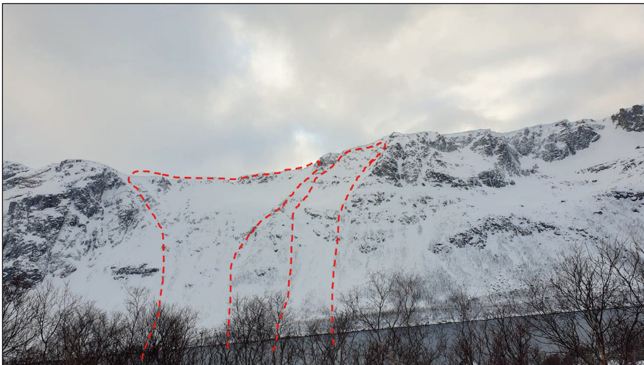
Figur 4: «Vågen» består av 2- 3 skredløp hvor det årlig går skred på veg. Gjelder skredløp Grøt fjorden II-III. (Foto: A. Persson).
