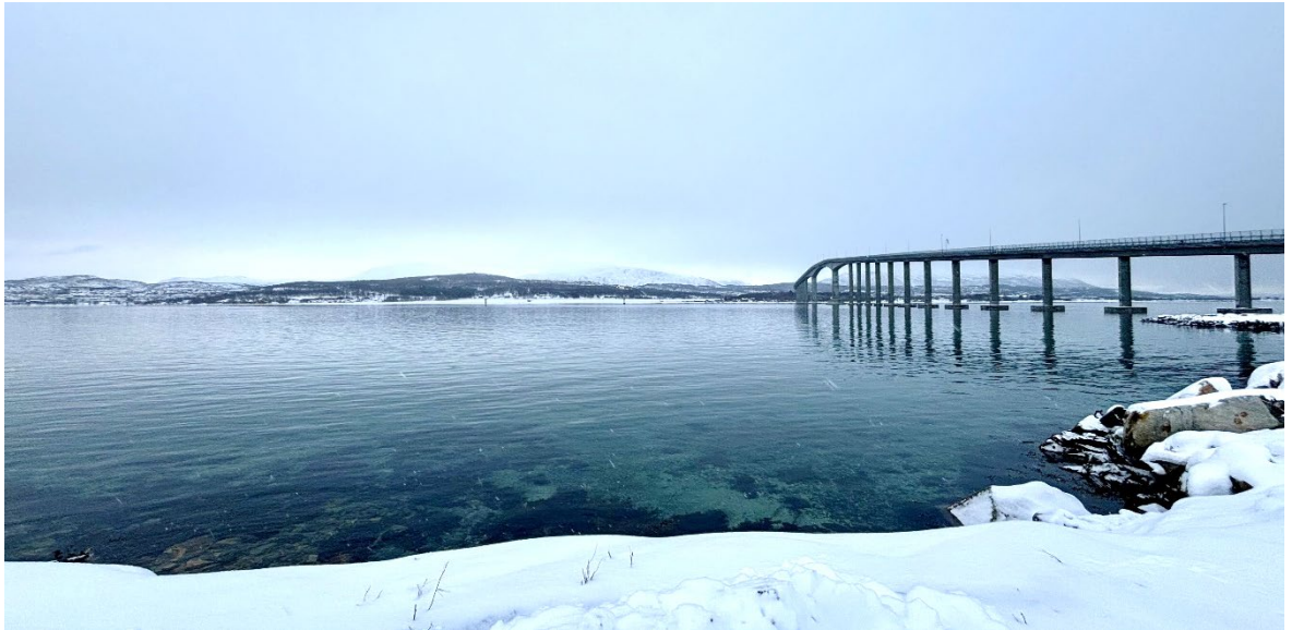
Figure 6-1: Sandnessundbrua sett fra nordsiden av brua på Kvaløy-siden. Brua er et fremtredende landemerke og fragmenterer landskapsrommet til delområdet i to (foto: COWI 2025).
