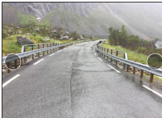
Bilde 1: Vågelv bru (Kilde: Brutus)
