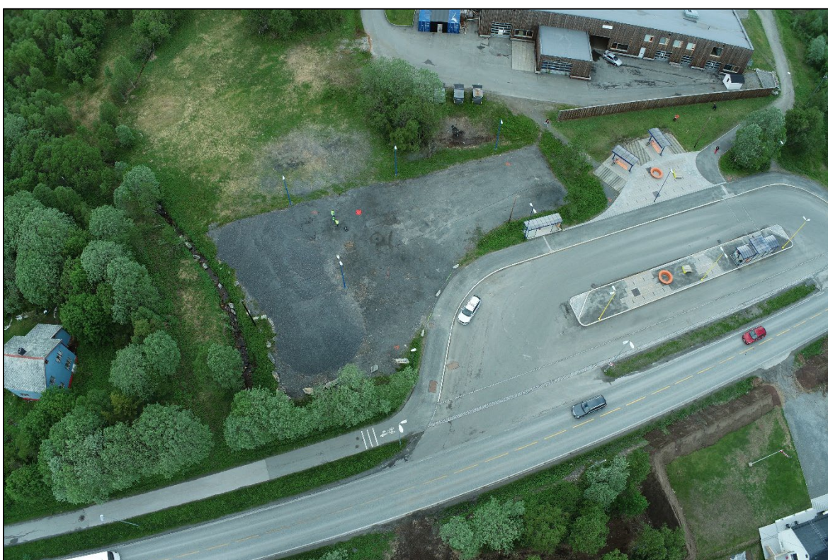
Bilde 3: Dronefoto av eksisterende situasjon ved Storelva bussterminal
