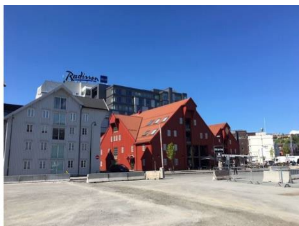
Høyre: Bevaringsverdige bygg innenfor (hvitt) og utenfor (rødt) planområdet.
