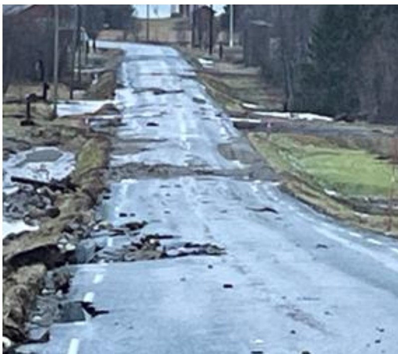
Illustrasjon: Effekt av værhendelse med flom og store ødeleggelser november 2024 på fv. 91 Breivikeidet. Foto: TFK/Samferdsel
