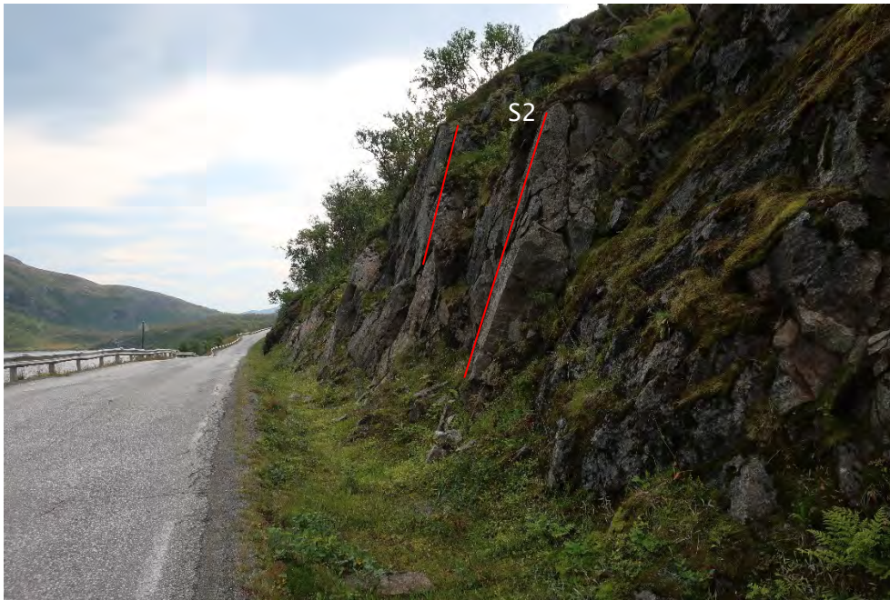
Foto 9: Eksisterende skjæring ved Stortvatnet hvor man her kan tydeligst se sprekkesett S2. Dette bildet er også tatt mot øst og mot profilretningen.
