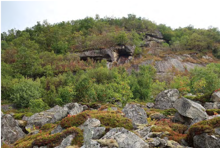
Foto 17: Bergvegg/skrenter over uren i ca profil 17360-17370. Dette er starten på steinsprangpunktet Kollen I.
