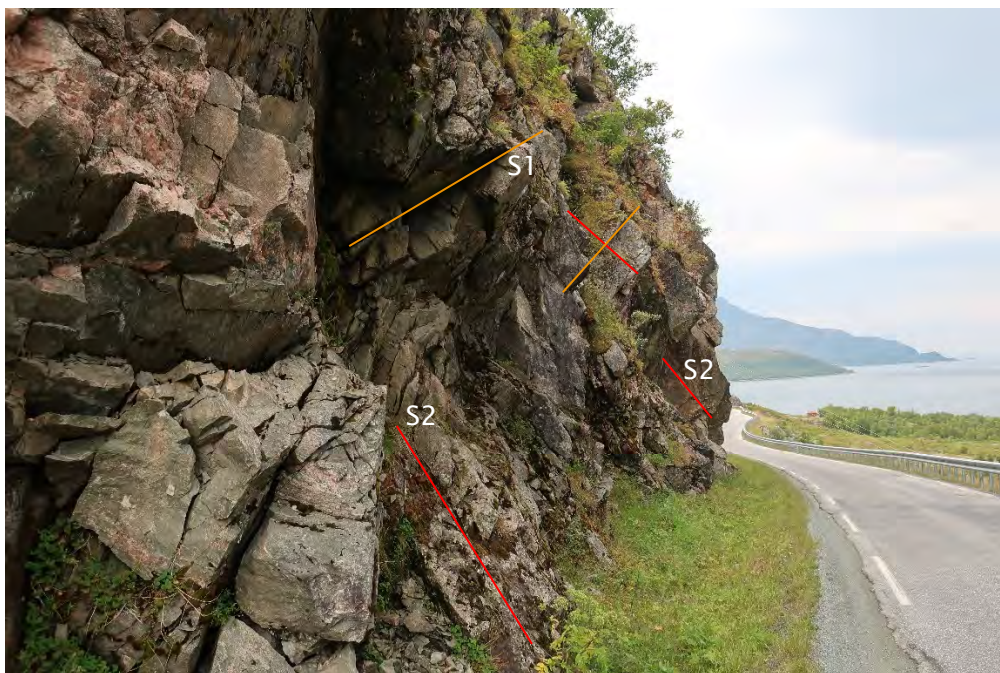
Foto 12: Eksisterende skjæring ned bakken mot Grøt fjord hvor man tydelig kan se sprekkesett S2 og S1. Bildet er tatt mot vest og med profilretningen.
