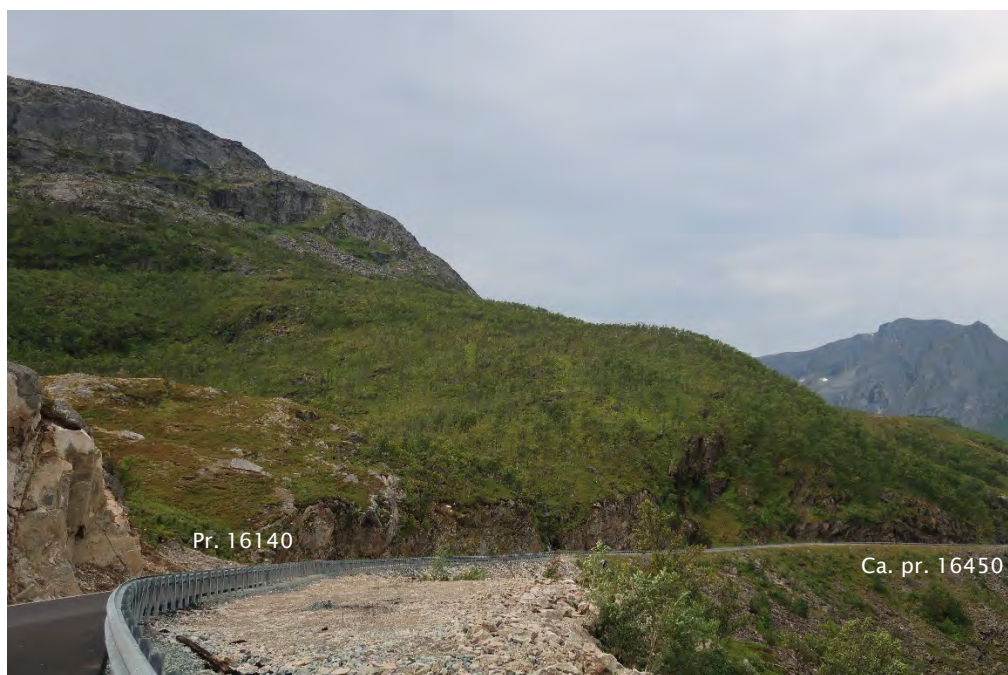
Foto 1: Oversiktsbilde over deler av vegen ned til Grøt fjord. Her er det høye eksisterende skjæringer, og det er planlagt en del nye høye skjæringer inkludert permanent hylle.
