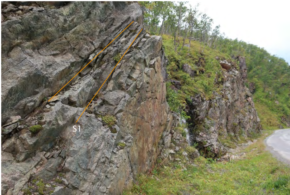
Foto 10: Her er sprekesett, S1, svært fremtredende. Bildet er tatt mot vest og med profilretningen.
