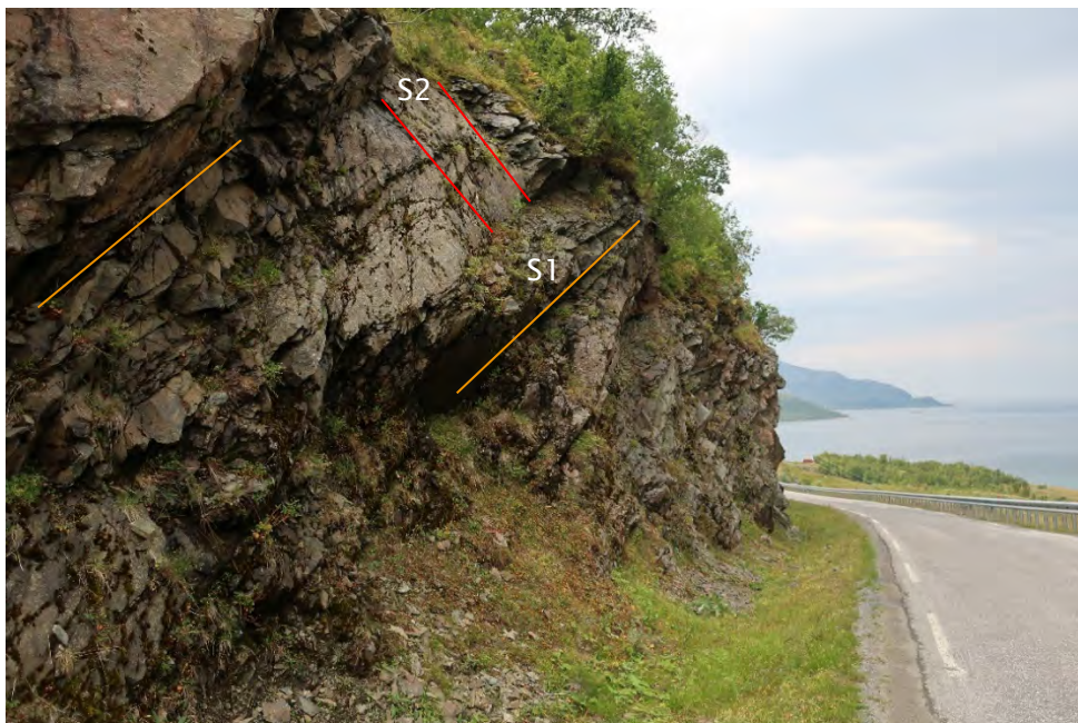
Foto 11: Eksisterende skjæring ned bakken mot Grøt fjord hvor man kan se sprekkeseettene S1 og S2, og et meget oppsprukket og forvitret berg. Bildet er tatt mot vest og med profilretningen.
