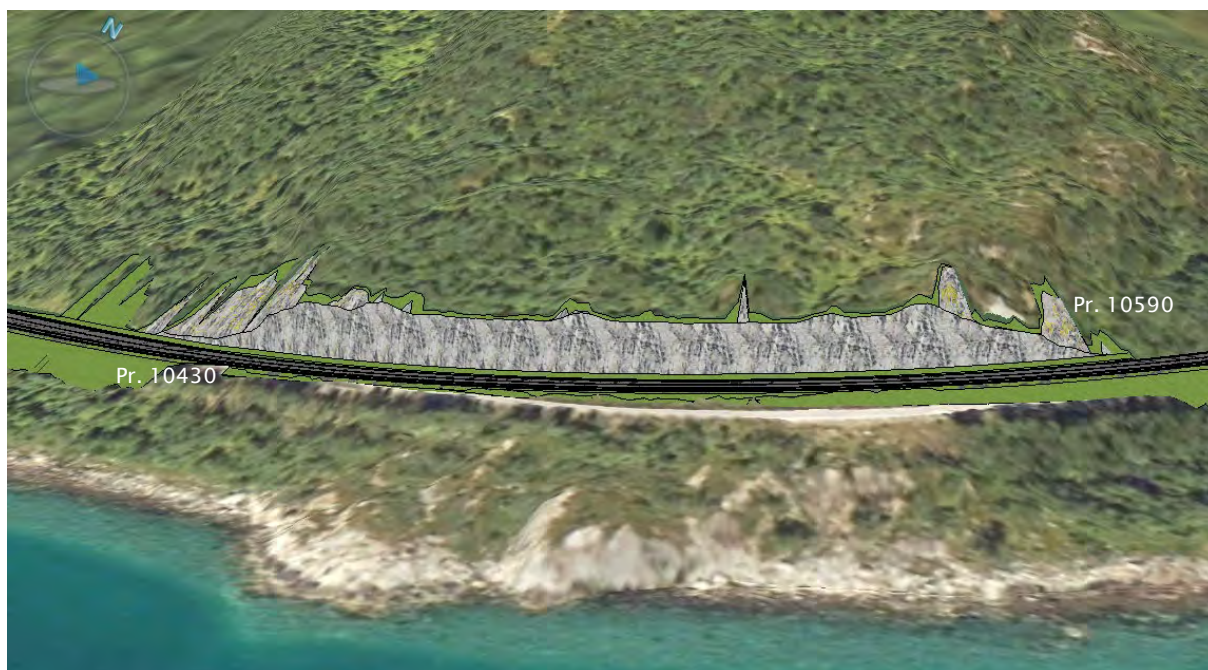
Figur 2: Bergskjæring mellom pr. 10430-10590 i linje 12200. (Se bort fra skråningsutslagene som stikker opp fra endene av bergskjæringen.)
