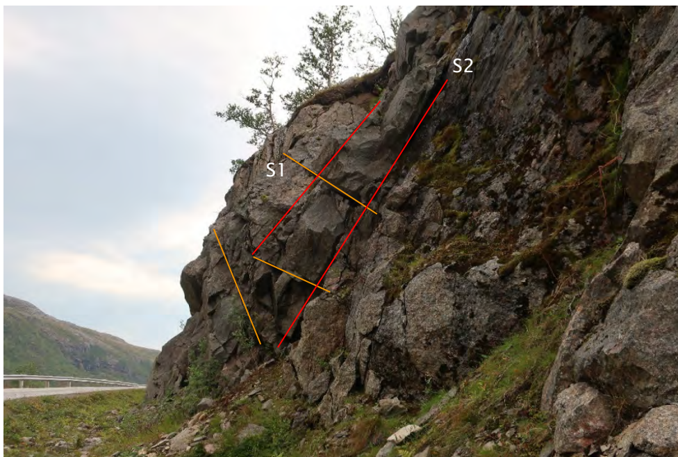
Foto 8: Eksisterende skjæring ved Storvatnet hvor man tydelig kan se sprekkesettene S1 og S2. Bildet er tatt mot øst og mot profilretningen.
