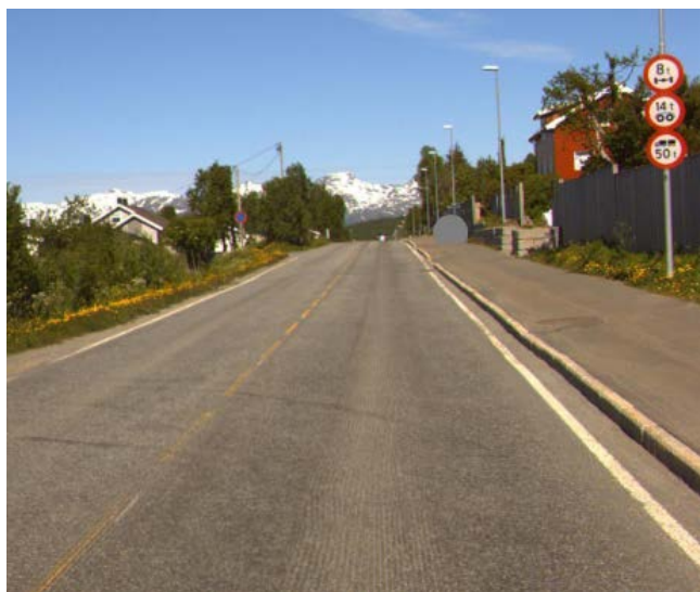
Fv. 864 har nedsatt aksellast til BkT8
