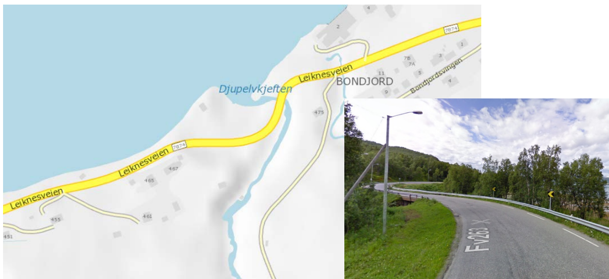
Kartutsnitt av Steindalselv bru (Djupeelva) ved Bondjord. Bilde fra Google streetview
